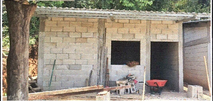
Foto 2: Reparación y mejoramiento general de cocina.
