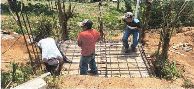
Foto 1: Mejoramiento general de sanitario y fosa séptica
