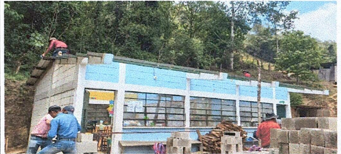
Foto 4: Mejoramiento y estructura de techado.
