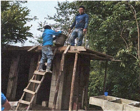
Foto 3: Mejoramiento general de sanitario y fosa séptica
